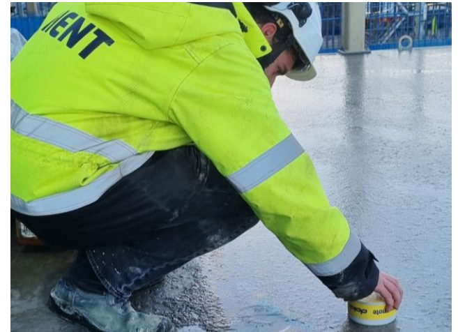
3) Měření pevnosti betonu raného stáří
