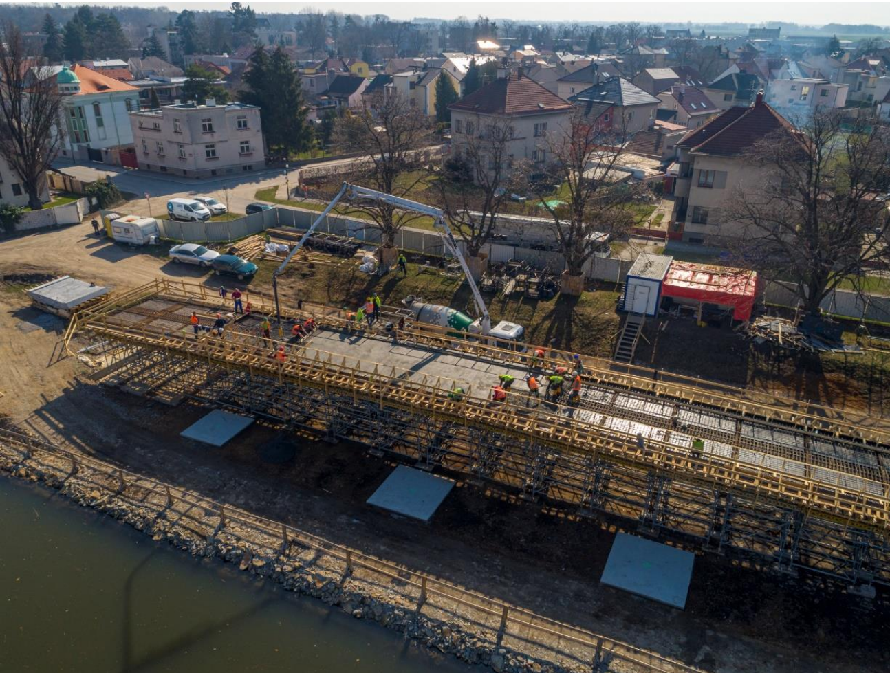
Výstavba lávky přes Labe v Nymburce - Dr. Petr Vítek
