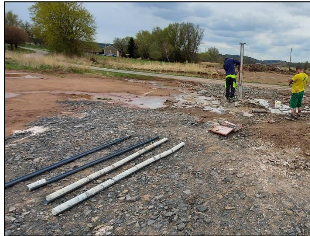
Provedení vývrtů po celé délce piloty.
