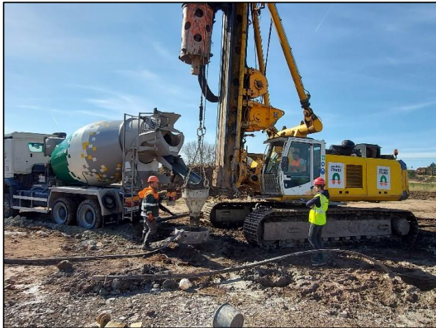
Experimentální ověření betonáže pilot s RA.
