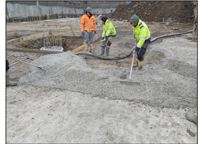
Lití podkladních betonů.
