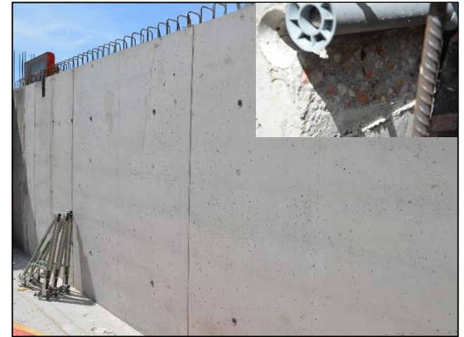
Výsledná stěna z betonu s 50 % náhradou recyklovaného kameniva.
