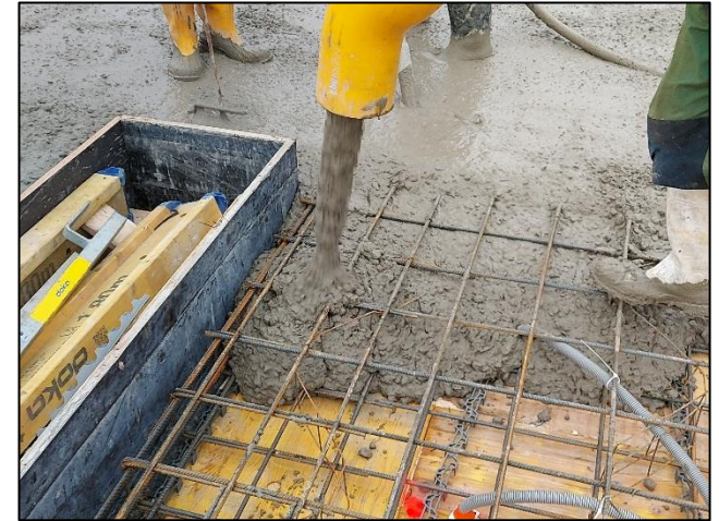
Lití stropních konstrukcí.
