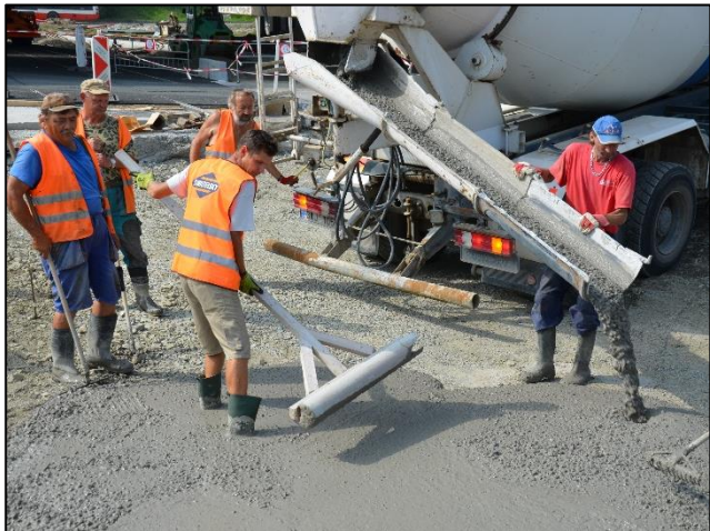
Optimalizace trati – podkladní betony.
