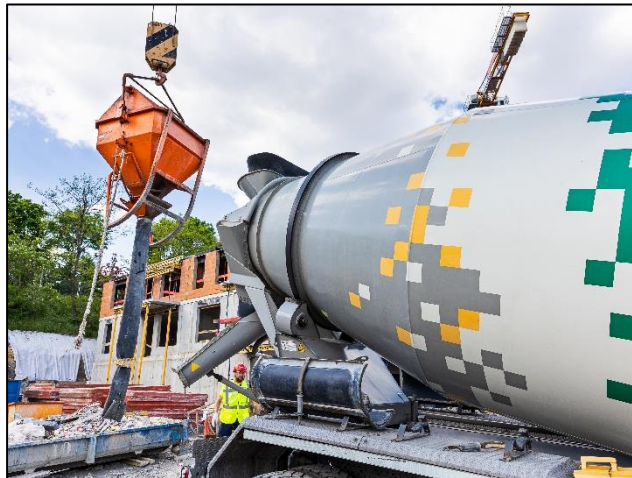
VESI Hostivař – podkladní betony a stěnové konstrukce.
